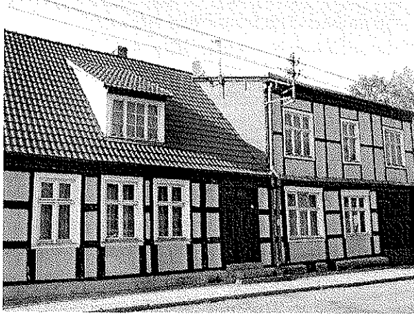
Fot. nr 8 – Dom na ulicy Wąskiej
